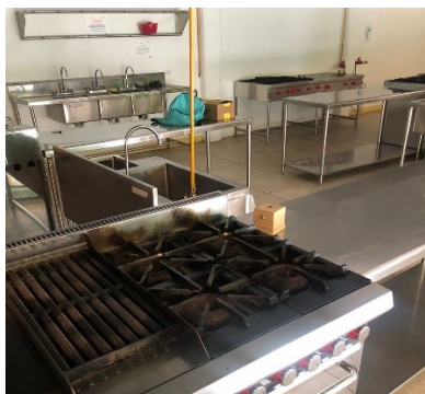
Figura 8. Instalación del equipo en cocina industrial. Fuente: Elaboración propia.
